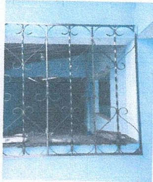
Foto 1: REMOZAMIENTO DE VALCONES
