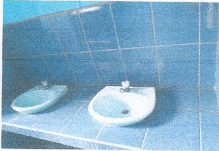
Foto 1: INSTAOLACION DE PISO CERAMICO EN LOS SANITARIOS
